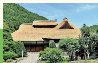
群馬県内では珍しい茅葺き屋根の曲屋「南郷の曲屋」。母屋や土蔵などを見学できる
